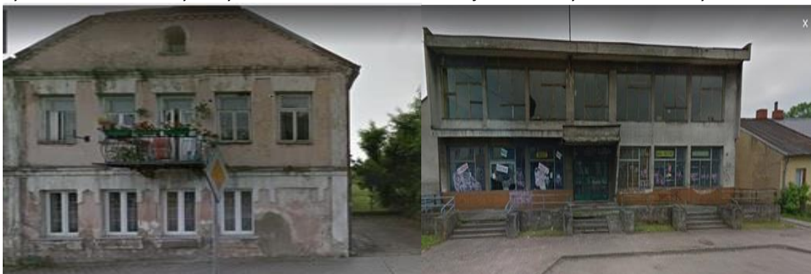
Rys 11. Stan techniczny budynków na obszarze rewitalizacji - ul. Łomżyńska w Szczuczynie
